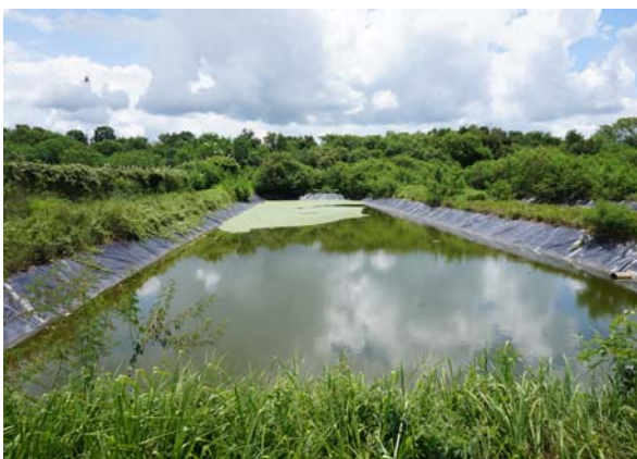
(ค) สภาพบ่อบำบัดน้ำชะขยะ
