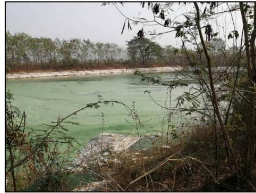
บ่อบำบัดน้ำเสีย
